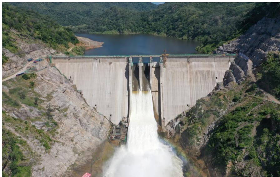
下凯富峡水电站大坝
